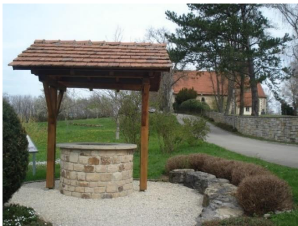
Rekonstruierter «Galbrunnen» im Süden der Kapelle, Foto vom Autor 2023
